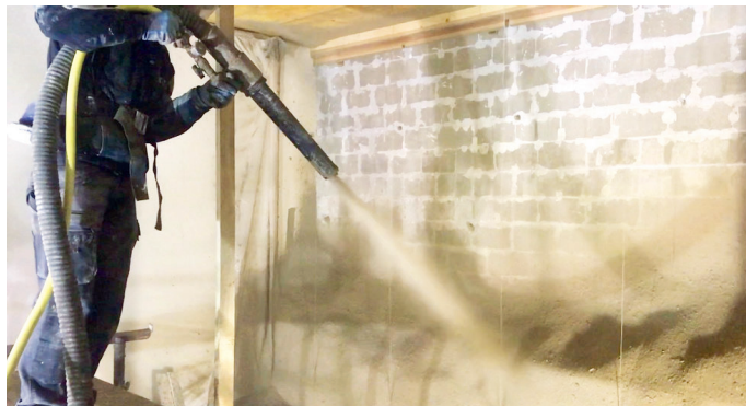
Shot-Earth remplace le béton par des matériaux d'excavation projetés à haute vitesse. Photo Pittet Artisans
