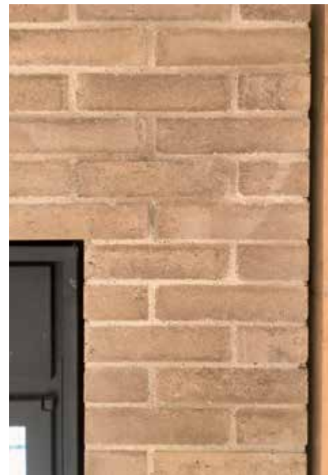
L'entreprise Terrabloc récupère des déblais d'excavation terreux issus de différents chantiers, évitant leur mise en décharge. Elle les transforme en blocs de terre compressée stabilisée. (© Atelier Hennemann Kamber)
