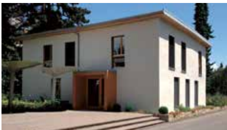
ECO-46, une construction qui abrite l'administration des parcs et domaines de la Ville de Lausanne. De l'extérieur, rien ne la différencie visuellement des autres bâtisses, malgré une construction en bottes de paille porteuse. (© 2014 Noé Cauderay)
