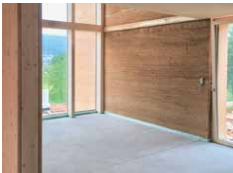
Mur en béton de chanvre avant enduit Maison Hennemann-Theurillat, Delémont (© Atelier Hennemann Kamber)
